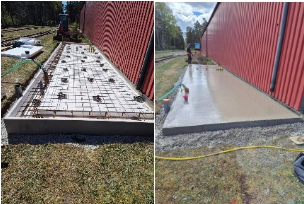
6 maj. Christers Gräv & Alltjänst armerade och lät gjuta bottenplattan till matarvattenboden.
