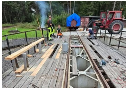
30 aug. Utbyte av murkna plank i vändskivans trädäck.
