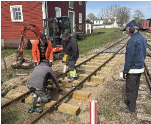
10 maj. Byte av slipers på spår 3 – Hesselby station.
