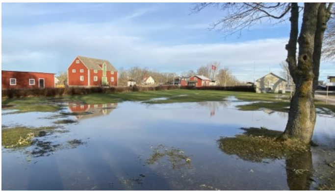
19 jan. Översvämmad gräsyta på Hesselby station.
