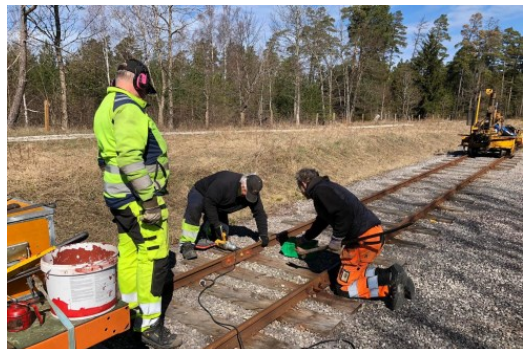
12 april: Dragning av skarvjärmsbultar vid Tule station.
