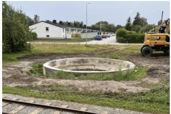
3 aug. Bruceasons gräv körde bort jordhögar kring vändskivan vid Roma station.
