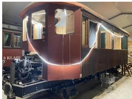
28 nov. MÅJ XC 10 med de nya välvda taken och monterad ytterpanel
