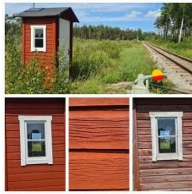
5 juli. Grusgropsspårets växelkur fick en mindre renovering.
