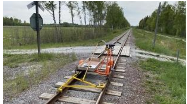
25 maj. Banbesiktning pågick med cykeldressin och mättrallan.
